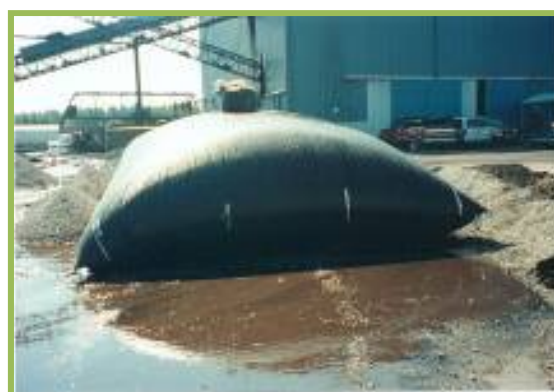
Figura 1.3.7-1: Sistema de disposição em tubo de tecido geotêxtil.
