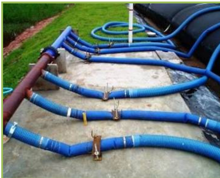
Figura 1.3.7-4: Barrilete de distribuição de sedimentos dragados para os Tubos de Geotêxtil.
