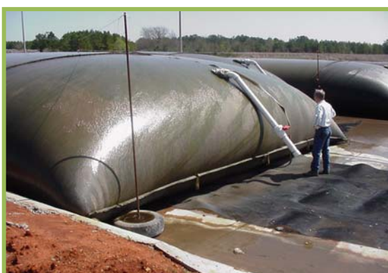
Figura 1.3.7-1: Sistema de disposição em tubo de tecido geotêxtil.
