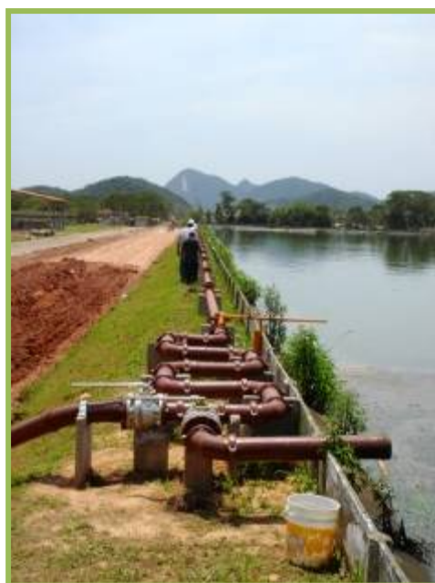
Figura 1.3.7-3: Sistema de dosagem de polímero.
