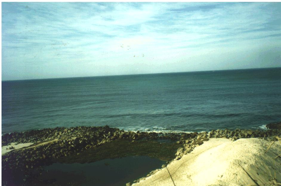
**Vista do Canal de Sernambetiba parcialmente obstruído pela colocação de enrocamento não permitindo a passagem da vegetação e acarretando a deposição de sedimentos. A maré não penetra no canal.**
