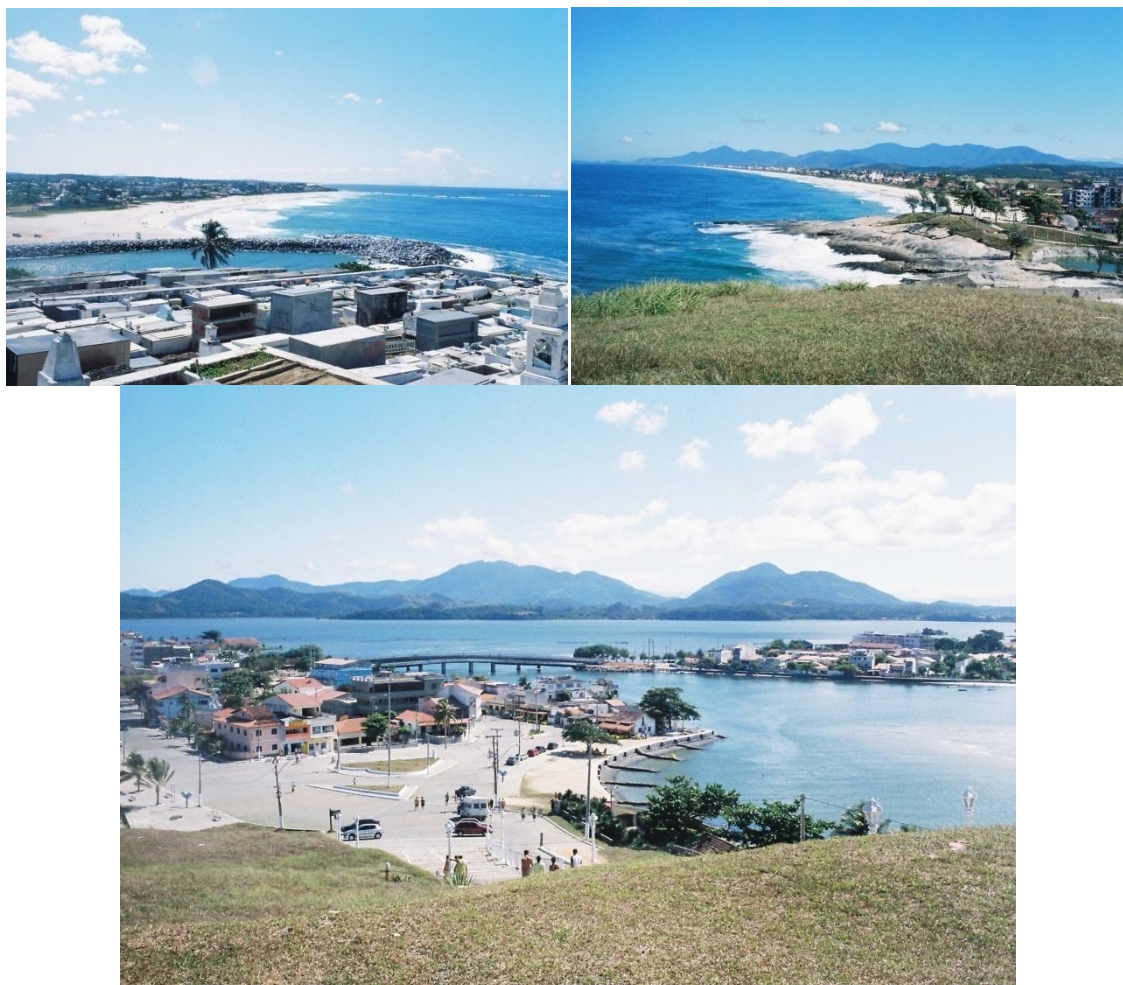
Figura 55: Embocadura da lagoa de Saquarema: guia-corrente na praia de Itaúna, vista para Oeste da praia de Saquarema e obras no canal. (Foto: C.F. Neves, 2007).
