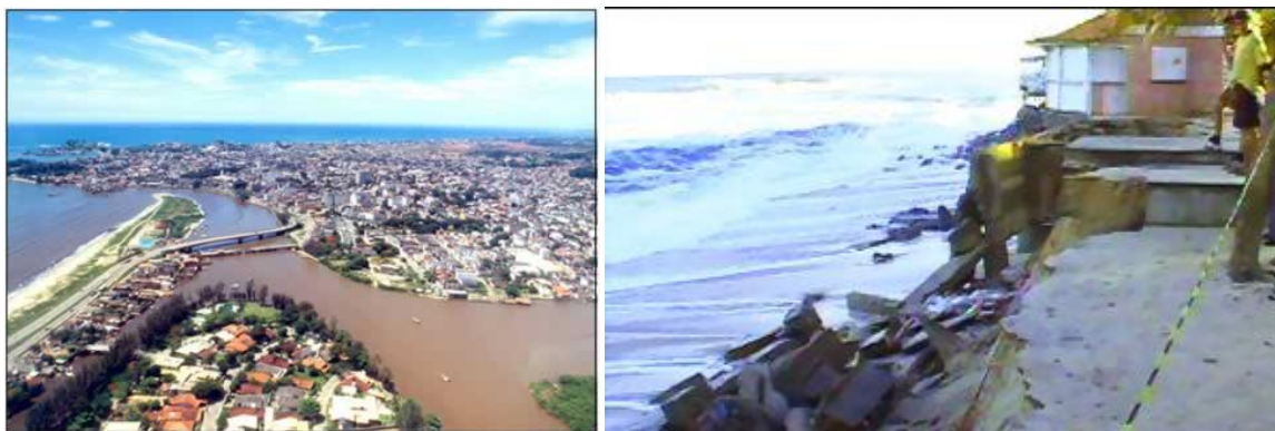
Figura 51: Barra do rio Macaé e destruição de casas após ressaca em agosto de 2007.
